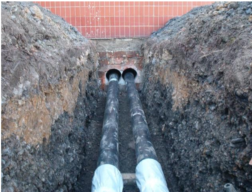
Obr. 4. Přívod předizolovaného potrubí do objektu s výměňkovou stanicí
