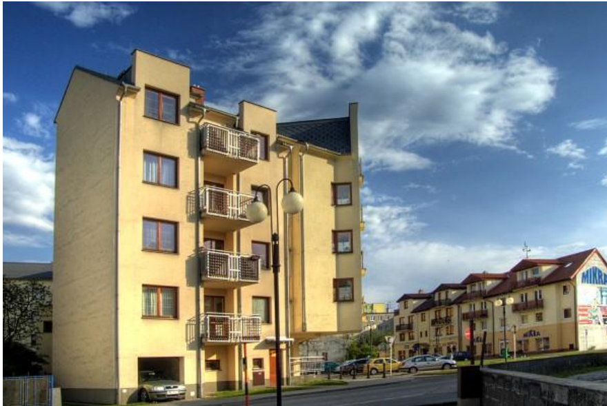
Výstavba ve Frýdlantu nad Ostravicí
