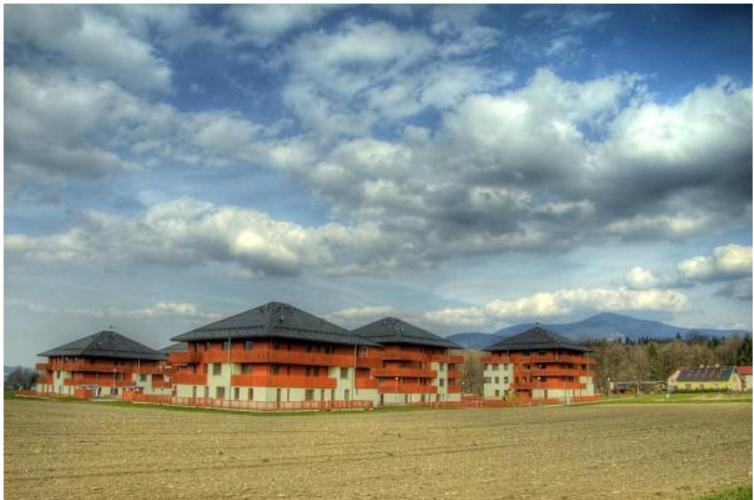
Výstavba na okraji obce Čeladná
