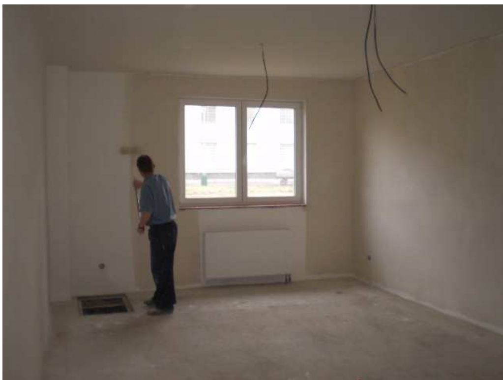
Obr. 28: Odsouzený P. M. maluje místnost nově rekonstruovaného objektu
