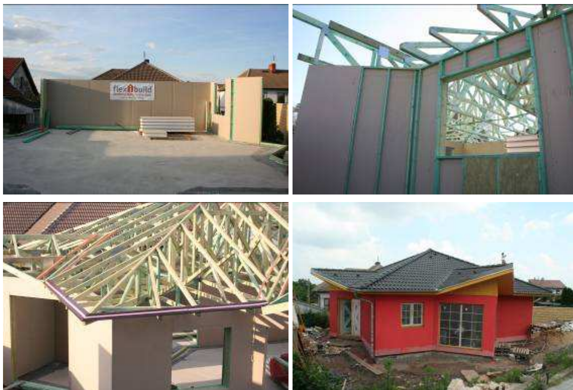
Obr. 5. Výstavba rodinného domu Flexibuild House
