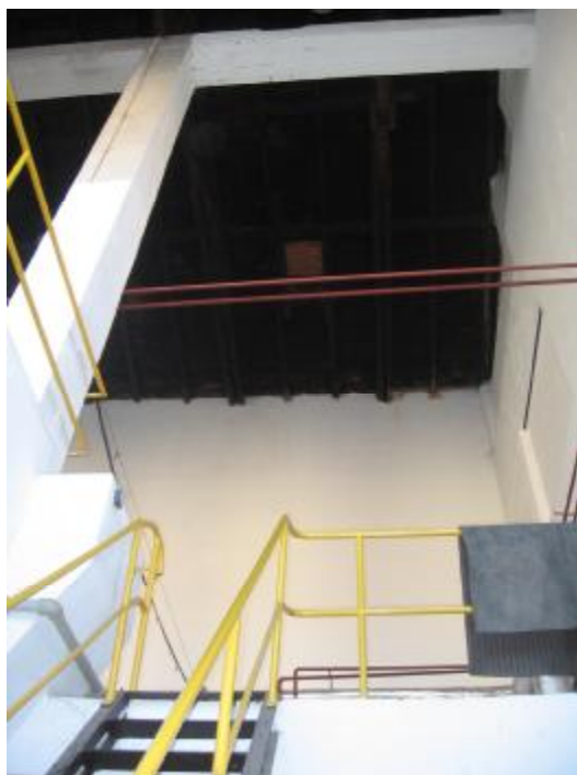
Obr. 9. Současný stav prostoru kotelny, pohled od vchodu do krovu
