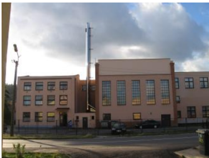
Obr. 34. Hlavní budovy areálu školy s kotelnou
