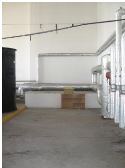
Obr. 10. Současný stav kotelny, pohled do mezipatra
