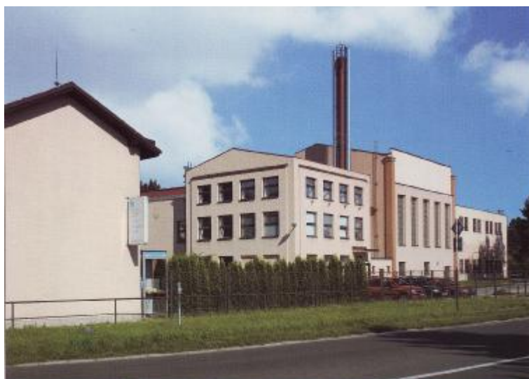
Obr. 8. Hlavní budovy školy s kotelnou
