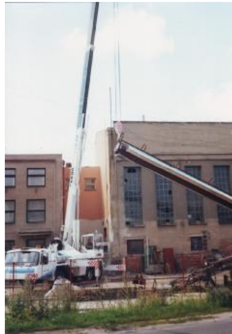
Obr. 3. Výměna komínu
