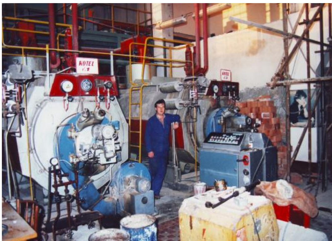
Obr. 6. Přestavba kotelny v roce 1996
