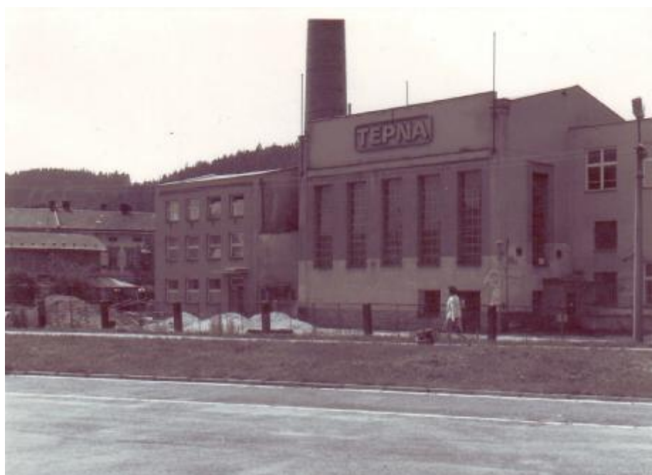
Obr. 1. Budova továrny v 80. letech
