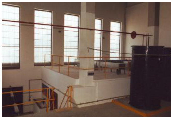
Obr. 12. Současný stav prostoru v mezipatře a patře
