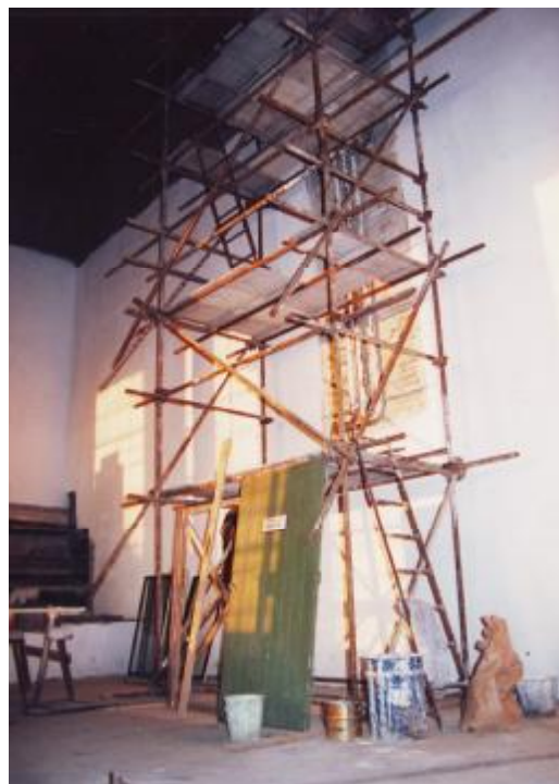
Obr. 5. Přestavba kotelny v r. 1996
