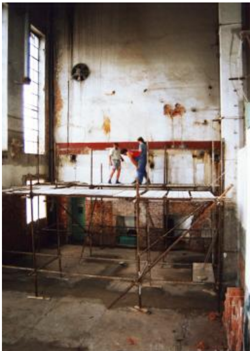
Obr. 4. Přestavba kotelny v r. 1996
