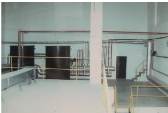
Obr. 11. Současný stav prostoru v patře a mezipatře
