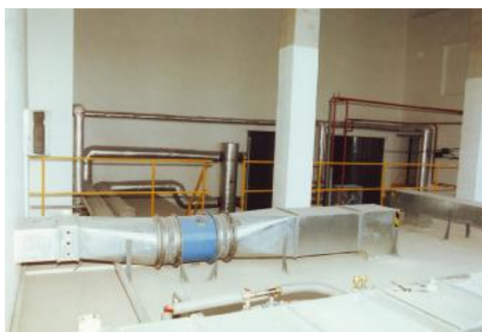
Obr. 13. Současný stav prostoru kotelny v patře
