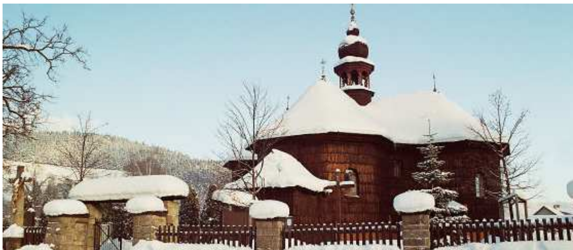
Obr. 4. Dřevěný kostel ve Velkých Karlovicích 13
