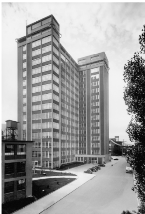
2. Jaroslav Bruner-Dvořák, 21. budova Baťova továrního areálu
