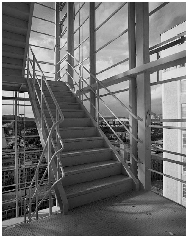
14. Studio TOAST, detail schodiště v jednadva- cáté budově
