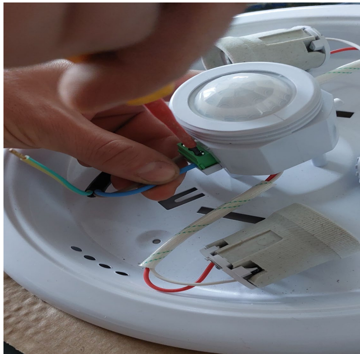
Obr. č. 50 Zapojenie svietidla ku káblu CYKY-O [vlastný]
