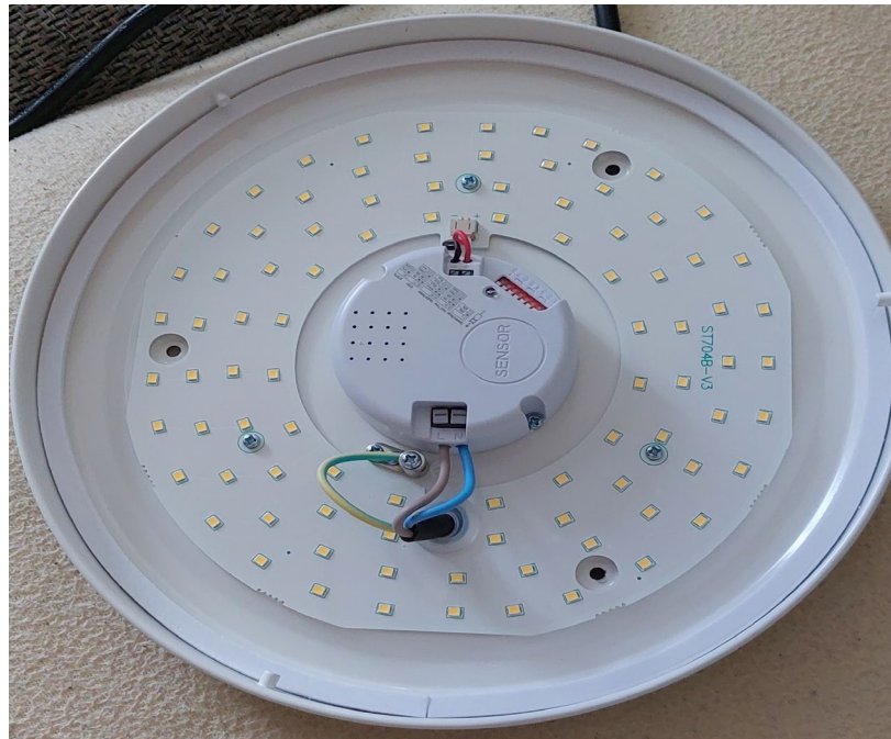
Obr. č. 62 Zapojenie druhého MW svietidla ku káblu CYKY-O [vlastný]
