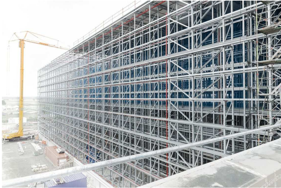
Obrázek 4 - Realizace stavby ocelové konstrukce, konkrétně skladového síla. (propagační materiály SSI)
