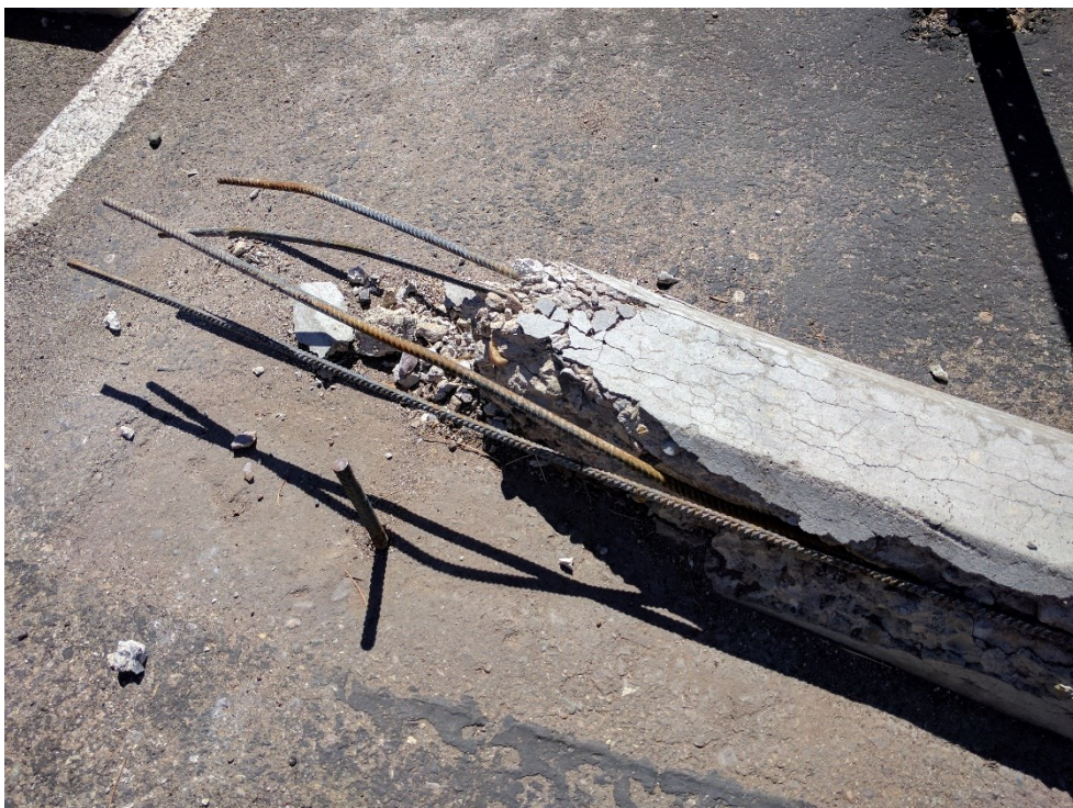
Obrázek 16: Železobetonová konstrukce, podélně umístěné ocelové tyče a na nich umístěný beton, příklad jednoho z nejstarších kompozitních materiálů [82]
