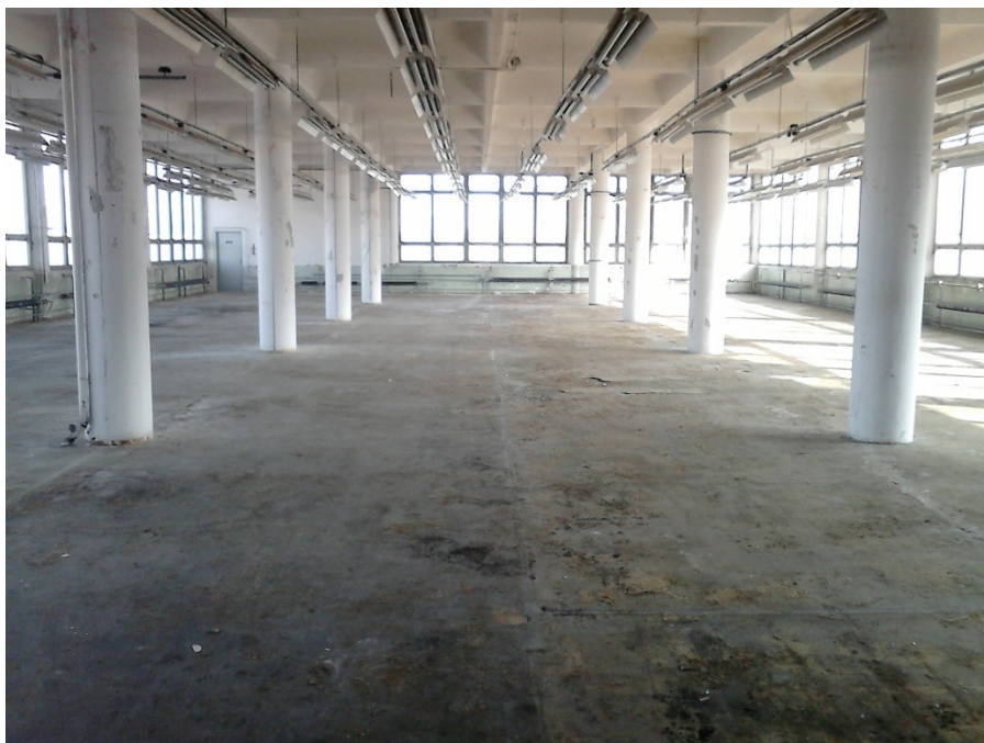
Obrázek 42 Budova 94 areál Svit
