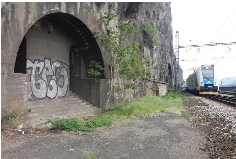
Obrázek 1 Vstup do bunkru v Mariánské skále Ústí n.L.
