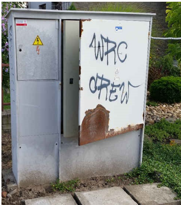
Obr. 8.4 Pohled na plastový pilíř rozváděče [10]
