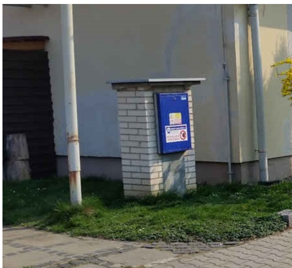
Obr. 7.3 Příklad zděného pilíře (neobsahuje telemetrii) [10]
