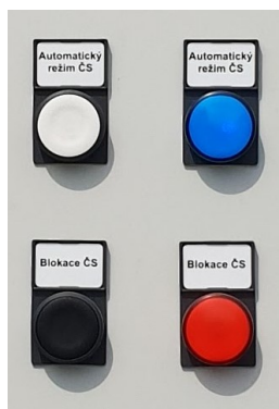
Obr. 8.8 Signalizace aut. režimu a blokace ČSOV [10]
