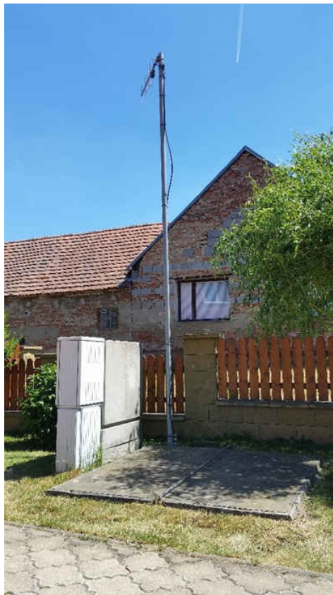
Obr. 7.1 Příklad plastového pilíře pro technologii, elektroměrového pilíře (vlevo) a stožáru s anténou pro telemetrii ČSOV. [10]
