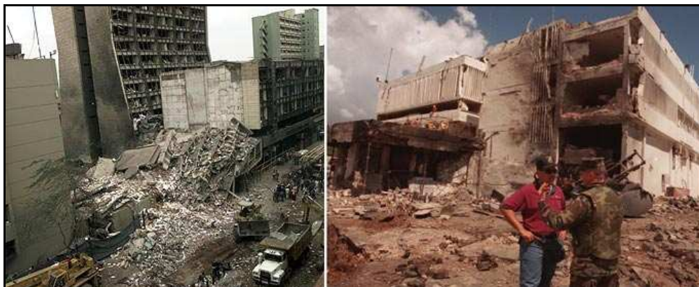
Obr. 13. Bombové útoky na budovy amerických ambasád v Keni (foto vlevo) a Tanzánii (foto vpravo) 32
