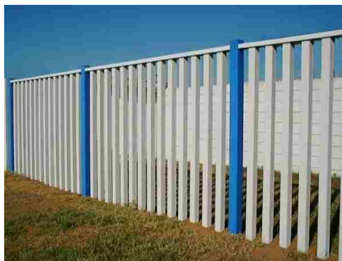
Obrázek 15 - Palisádové oplocení z ocelových „kůlu“
