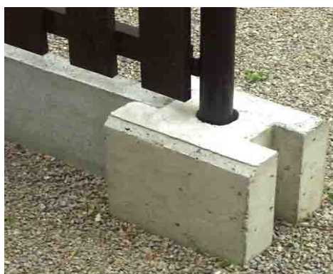
Obrázek 24 - Detail betonového stabilizačního držáku
