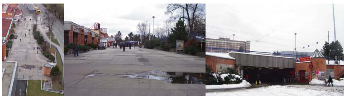
Obr. 41 Současný stav podchodu a zastávky MHD, Náměstí Práce 2009
