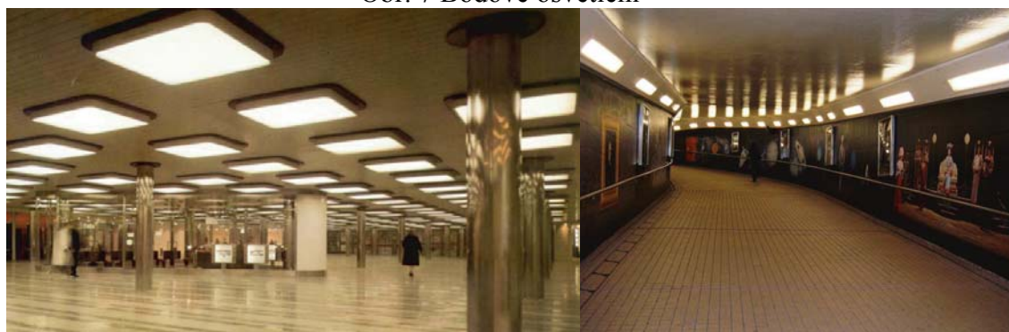
Obr. 8, 9 Osvětlení pravoúhlými svítidly
