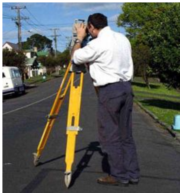
Obr. 42 Geodetické vyměřování místa DN
