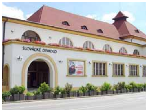
Obr. 54. Budova Slováckého divadla v Uherském Hradišti
