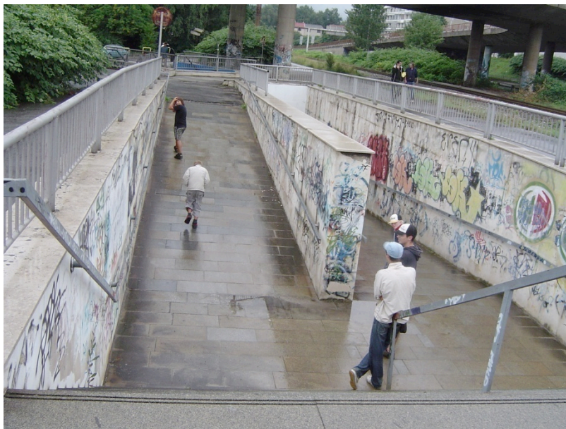
Obr.15 – Snímek před zahájením rekonstrukce
