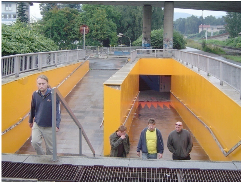
Obr. 16 – Snímek po dokončení rekonstrukce
