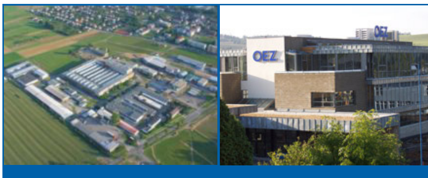
Obrázek č. 6 – Pohled na administrativní budovu (vpravo)
