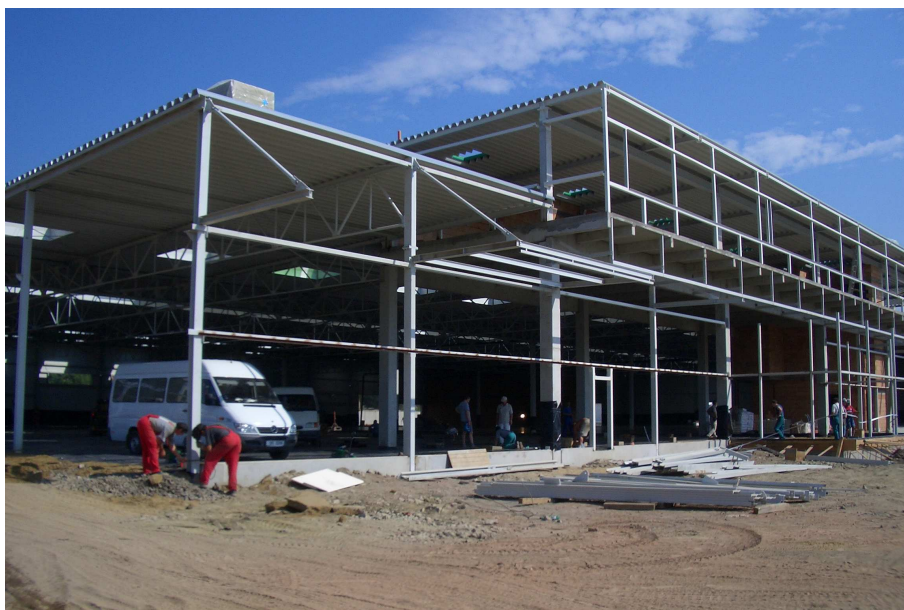
Celkový pohled na ocelovou konstrukci administrativní části a prodejny
