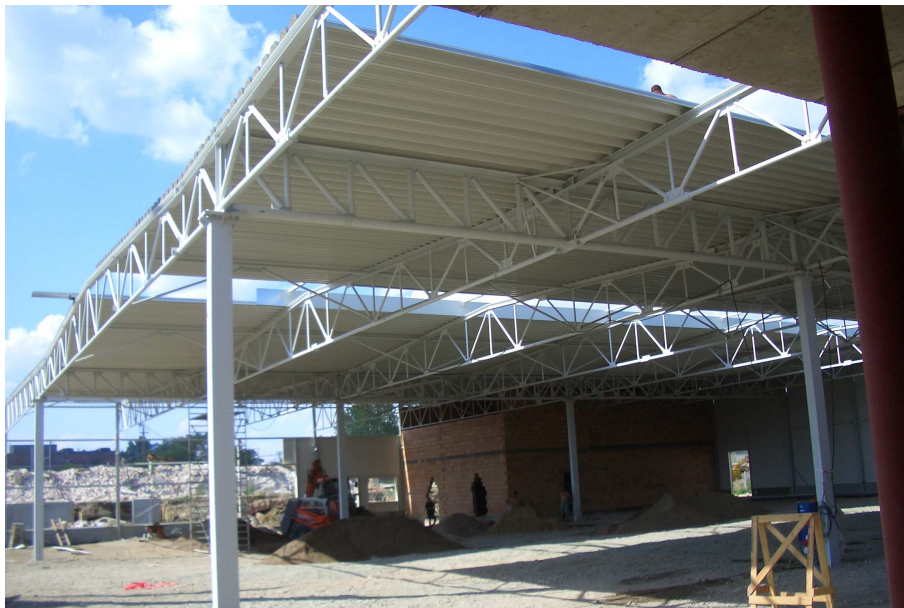
Ocelová konstrukce prodejny
