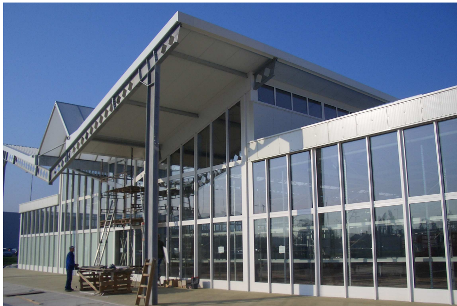
Ocelová konstrukce zahrady
