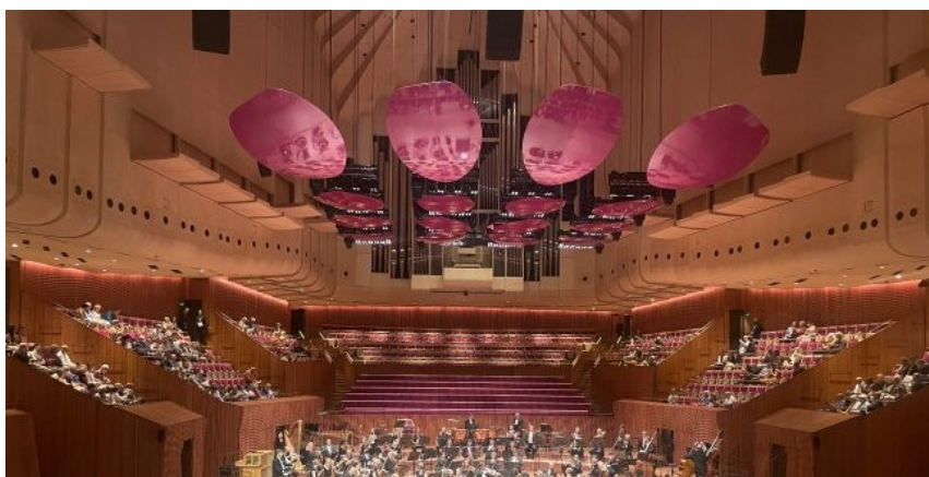
Obrázek 37 Stropní akustické panely opery v Sydney 105
