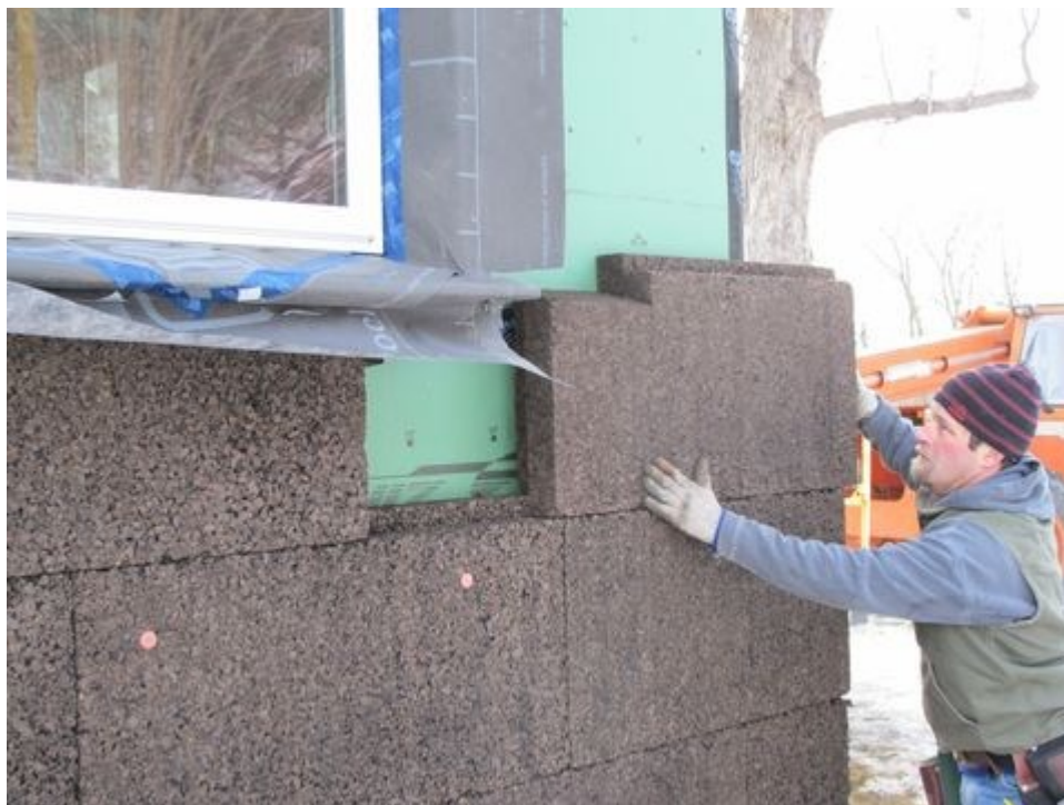
Obrázek 18 Instalace korkové izolace 62
