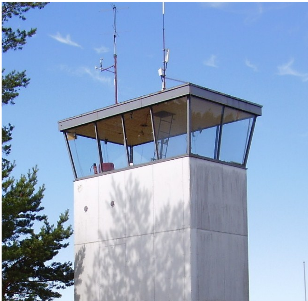
Obrázek 25. Räyskälä airport small ATC – Finsko 36
