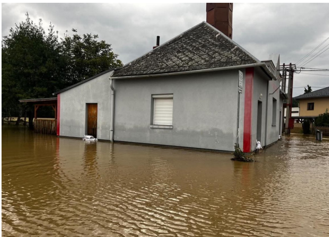
Obrázek 24 Hasičská zbrojnice SDH Dvořisko (zdroj: Facebook města Kravaře, 2024)
