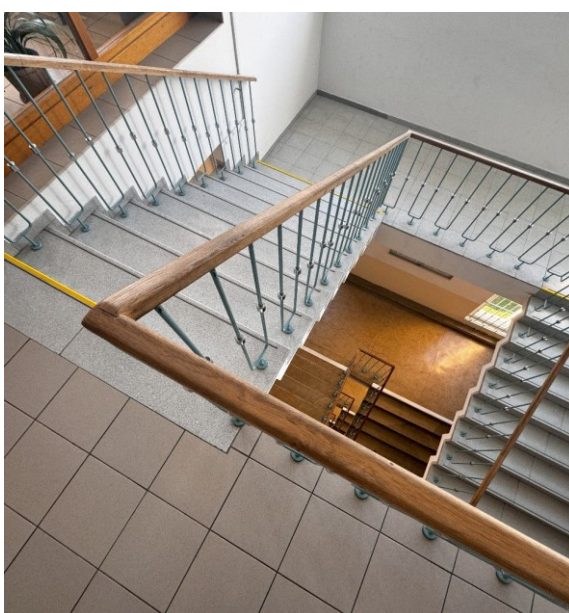
Obrázek 14 Hlavní schodiště střední školy č. 2
