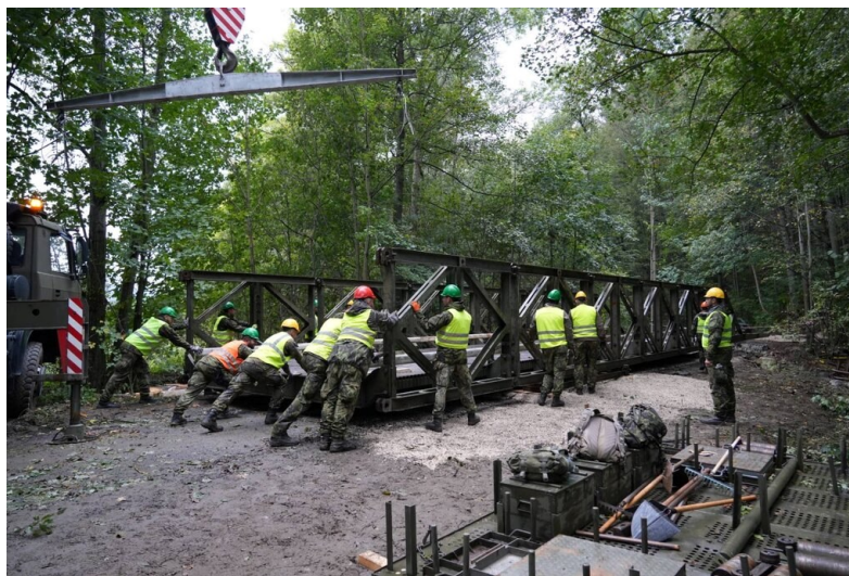
Obrázek 11 Stavba mostního provizoria
