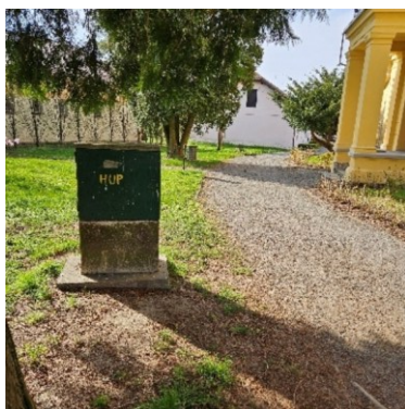
Obrázek 14 Hlavní uzávěr plynu
