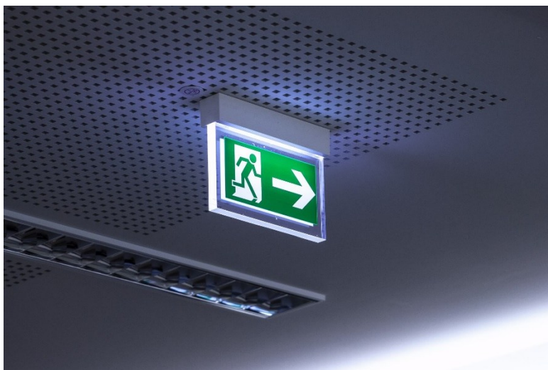
Obrázek 1 Evakuační osvětlení
