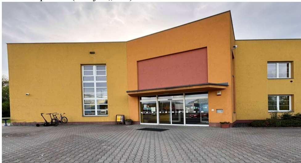
Obrázek 6 Budova Krytého bazénu ve Valašském Meziříčí
