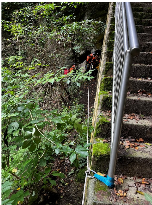
Obrázek 19 Lanové zábradlí k hornímu kotevnímu bodu
