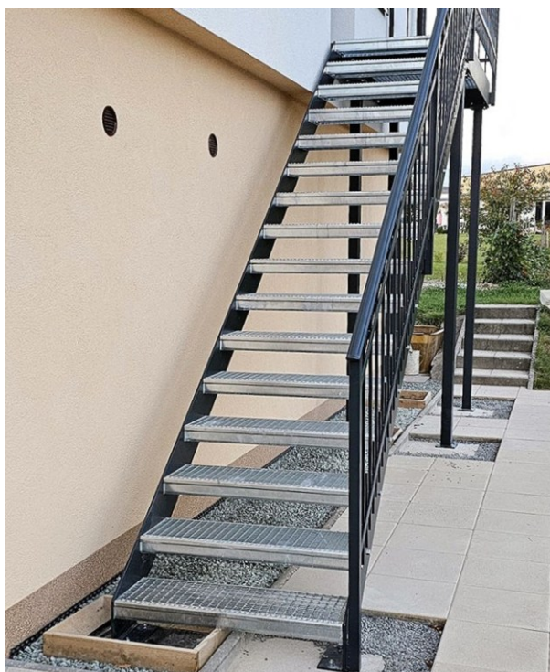
Obrázek 25 Schodiště s oboustrannými schodnicemi
