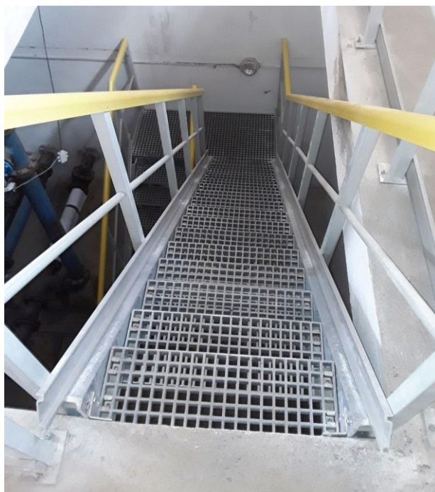
Obrázek 26 Schodiště z kompozitních materiálů s roštovými schodnicemi
