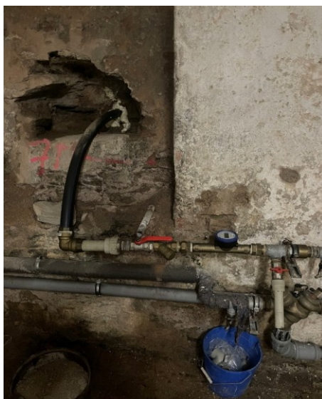
Obrázek 7 Hlavní uzávěr vody v suterénu.
