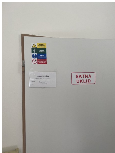
Obrázek 6 Místnost, kde se nachází hlavní jistič a vchod do suterénu budovy.
