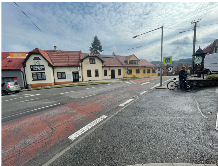
Obrázek 18 Nevyhovující stav přechodu pro chodce
