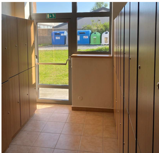
Obrázek 12 Únikový východ z podzemního podlaží nové přístavby.
