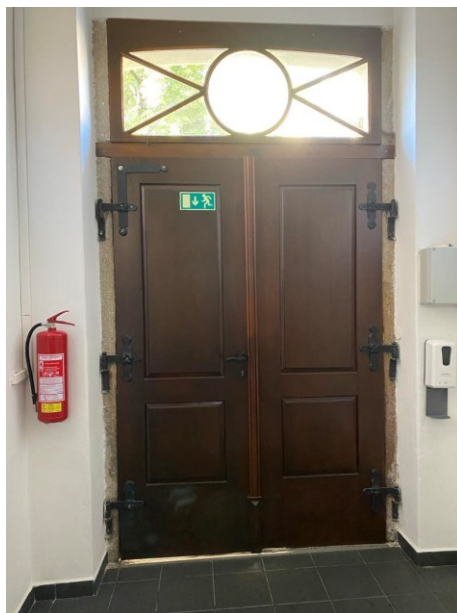
Obrázek 15 Únikový východ v původní budově školy.
