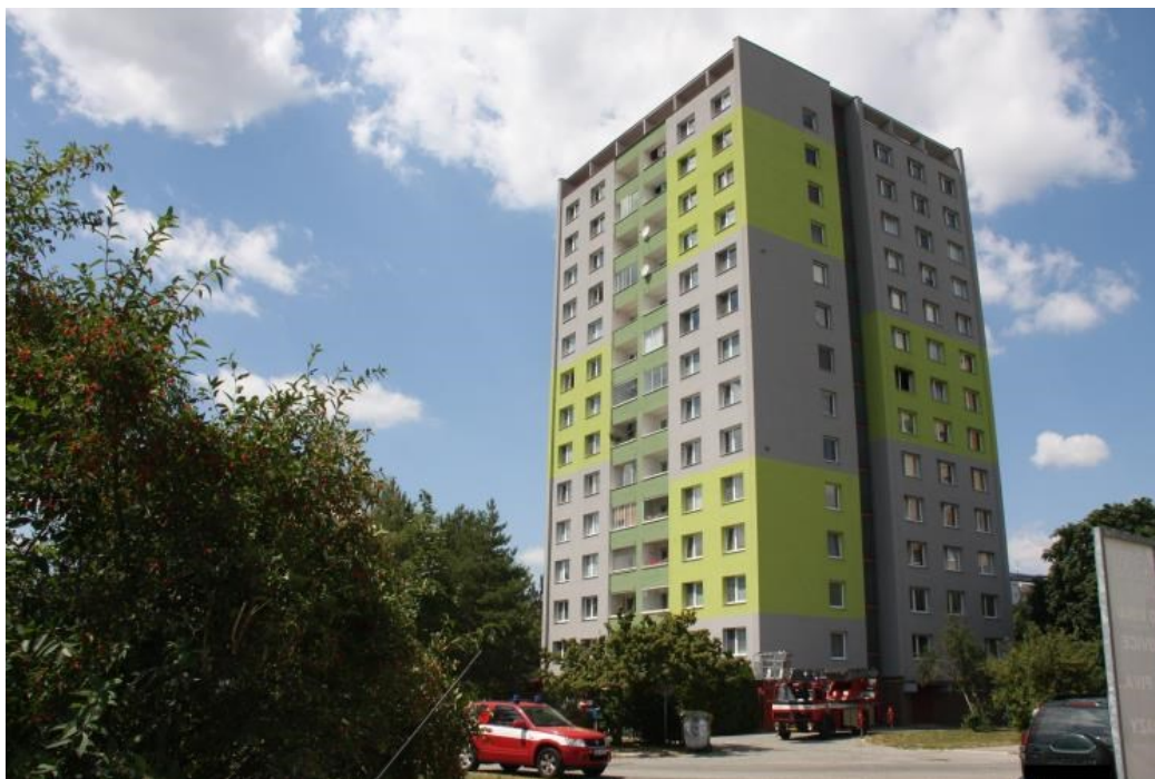
Obrázek 11 Požár bytového domu
