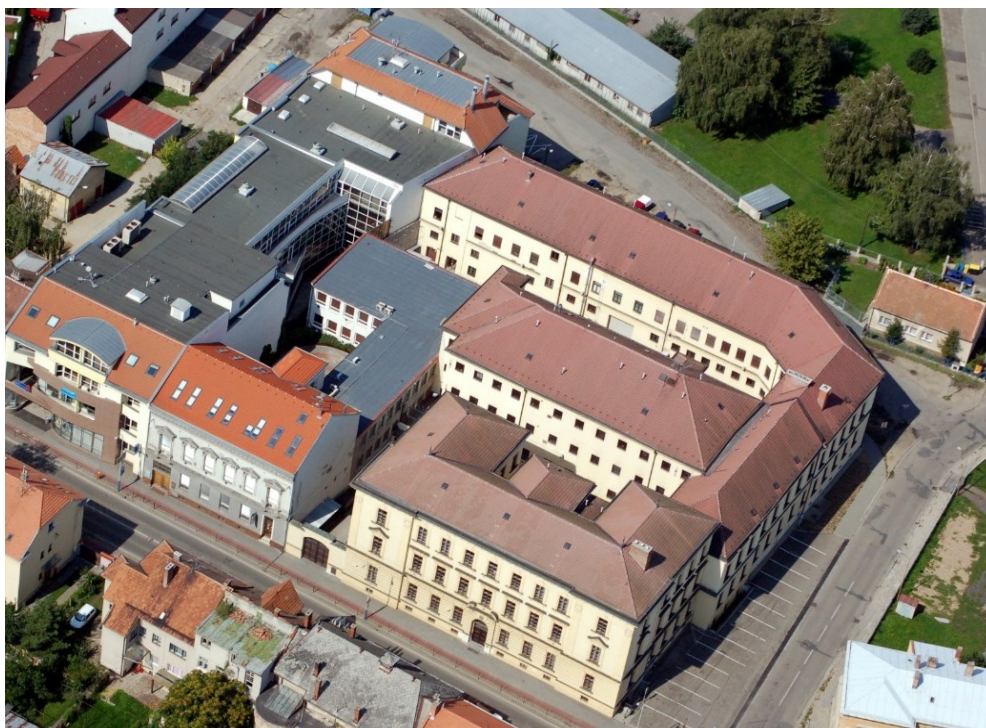
Obrázek 5 – Věznice Břeclav, objekt Břeclav
