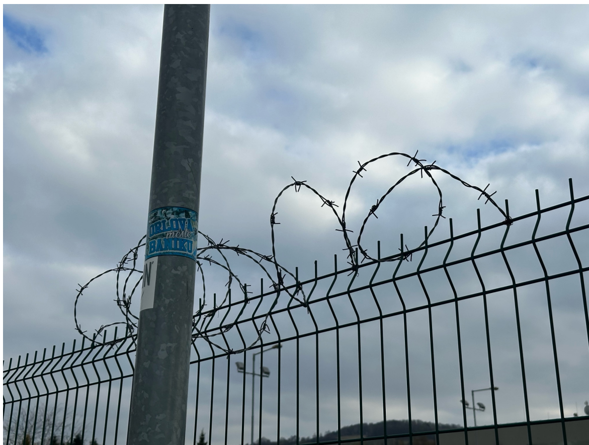
Obrázek 13 – Opatření proti překonání plotu v místě sloupu.
