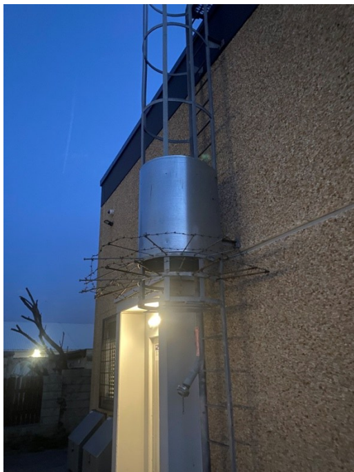
Obrázek 13 – Žebřík zabezpečený bezpečnostními dvířky a ostnatým drátem
