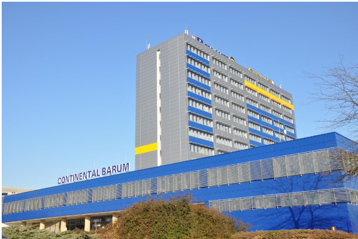
Obrázek 1 – Administrativní budova společnosti (Interní zdroj Continental Barum, s.r.o.)
