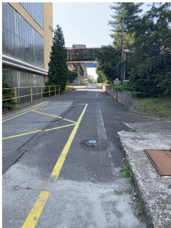
Obrázek 23 Cesta mezi skladem 55 a výrobou 101 (Zdroj: Vlastní zpracování)
