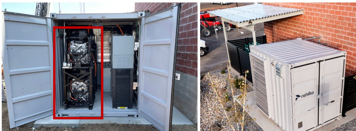
Obrázek 12 Záložní zdroj PEMFC o výkonu 100 kW pro nemocnici ve státě Washington, zvýrazněny jsou palivové články
