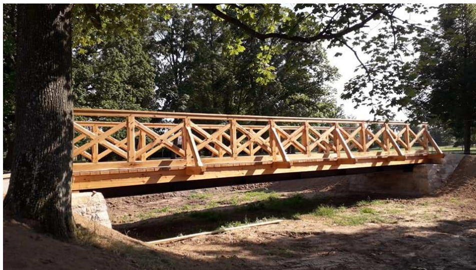
Obrázek 5 Rekonstrukce dřevěného mostu v zámeckém parku
