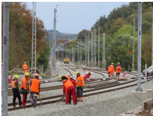
Obrázek 1 Stavba železniční tratě
