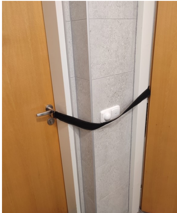
Obrázok 75 Uchytenie opasku o kľučku dverí
