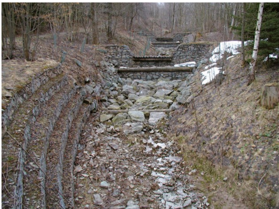
Obrázek 56 – Ukázka gabionové stěny pro zpevnění břehu [76]
