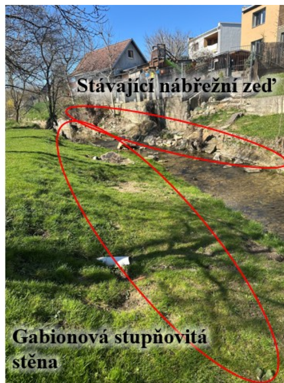
Obrázek 96 – Návrh umístění gabionové stěny podél pravého břehu toku Klanečnice [vlastní]
