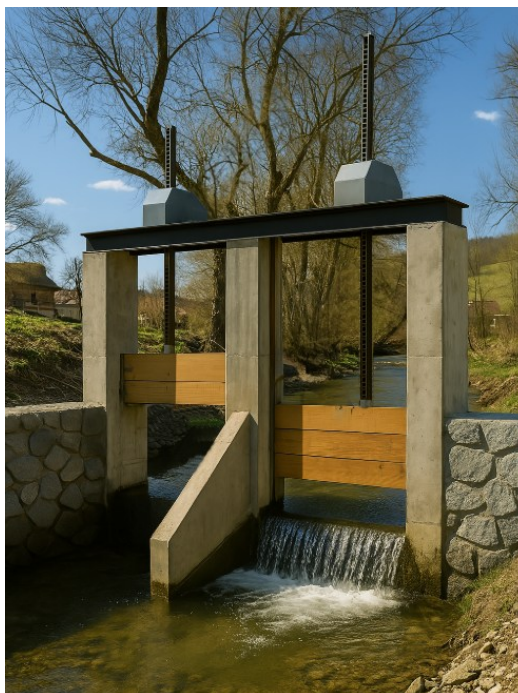
Obrázek 51 – Vstupní regulační objekt stavidlo na přítoku postranních ramen do nádrží [74]
