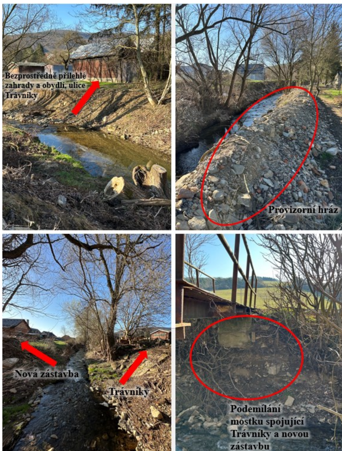
Obrázek 57 – Aktuální stav toku Klanečnice podél ulice Trávníky [vlastní]
