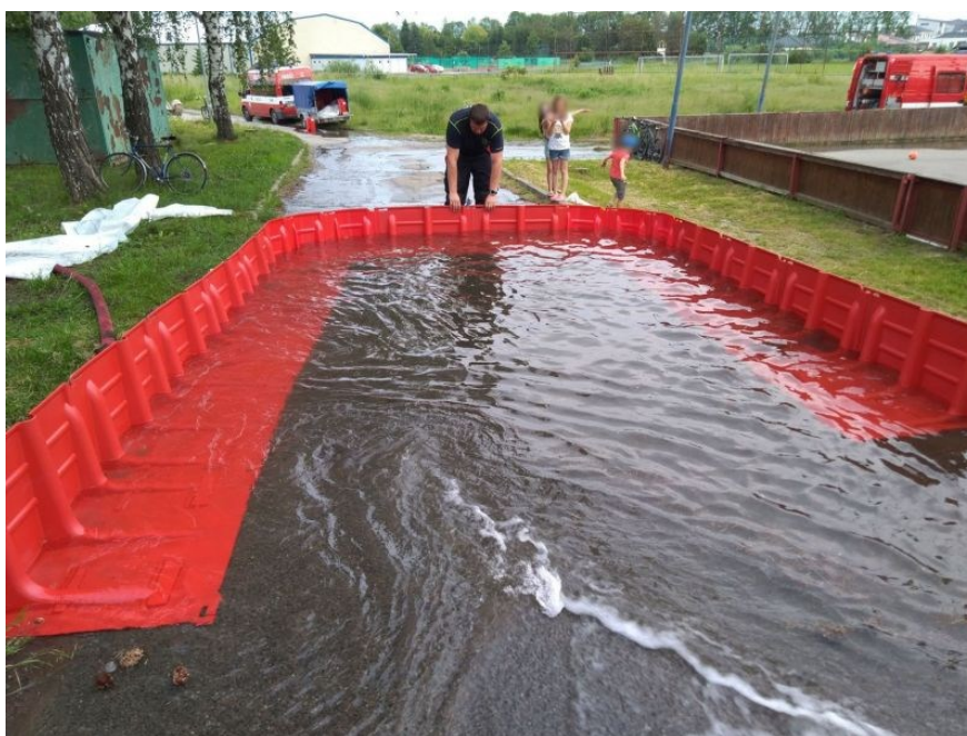
Obrázek 106 – Povodňová zábrana NOAQ BoxWall WB102 [93]
