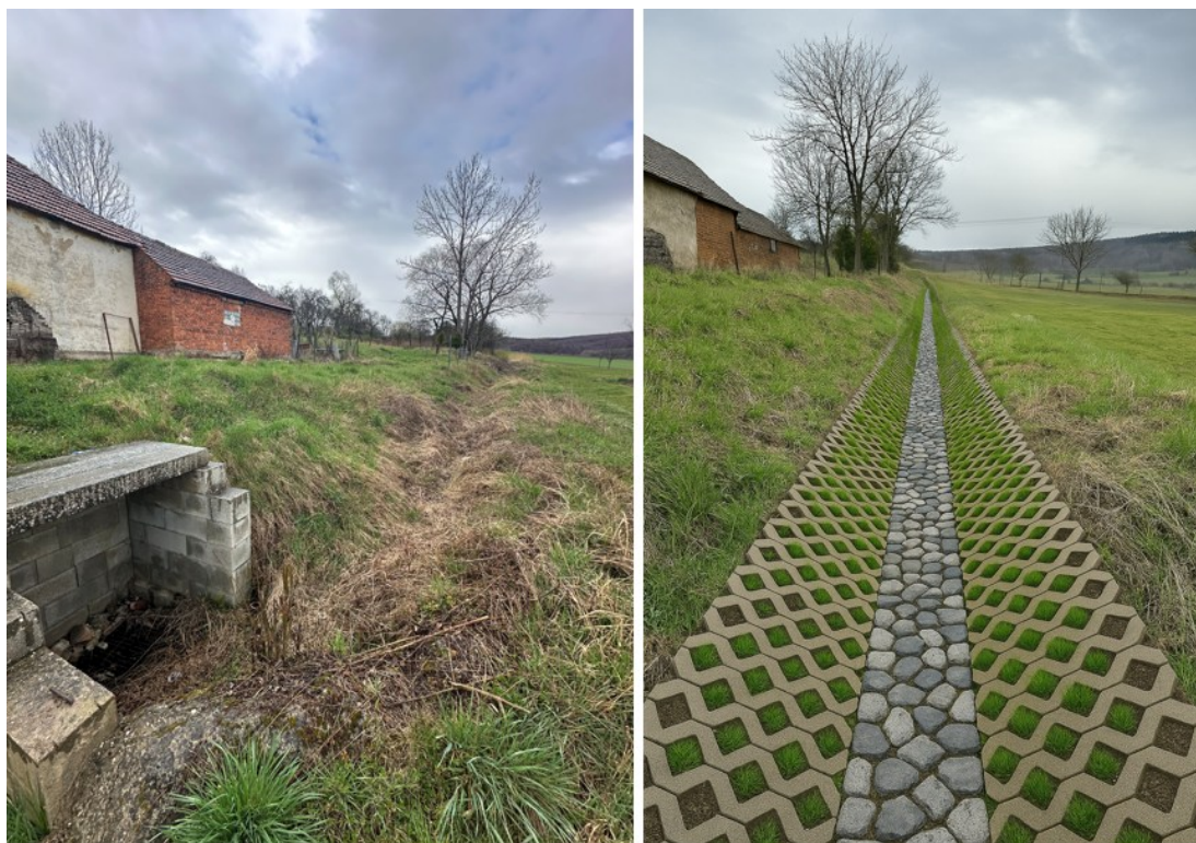
Obrázek 38 – Nový zachytňový příkop pro oblast č. 1 [74]
