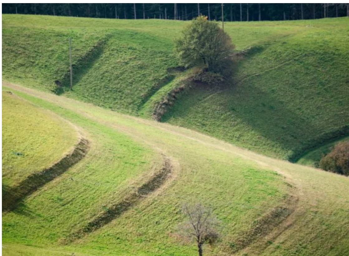
Obrázek 43 – Ukázka zasakovacích příkopů, tj. svejlů [82]
