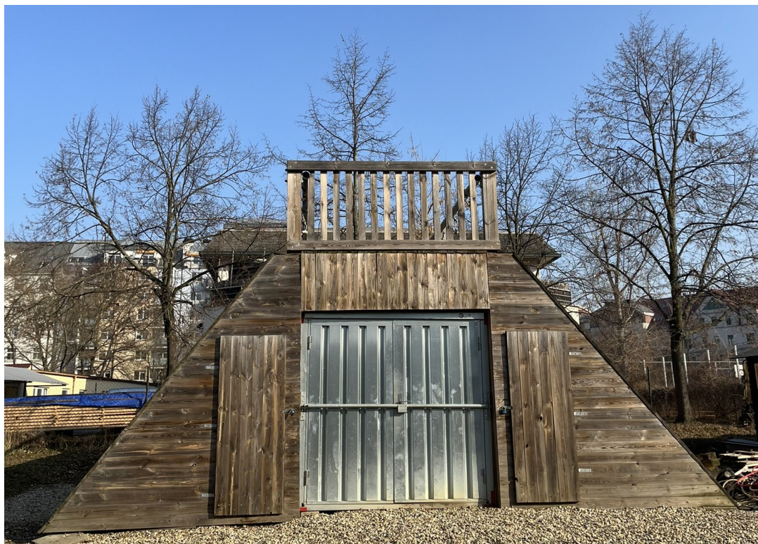
Obrázek 8 Zabezpečení prostorů pod tréninkovou stěnou
