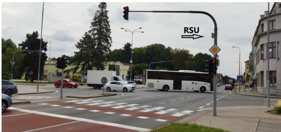
Obrázek 43 Umístění RSU na SSZ
