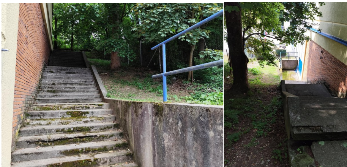
Obrázek 27 Schody v zadní části areálu
