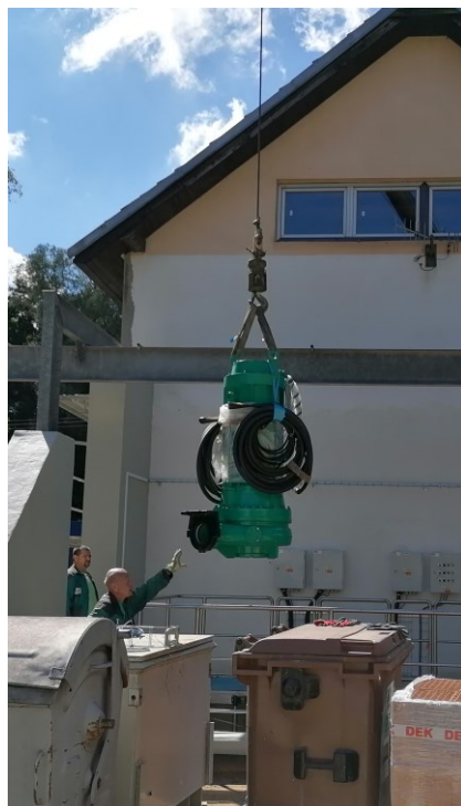
Obrázek 15 Instalace čerpadla Willo [21]
