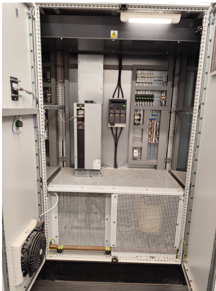
Obrázek 16 Frekvenční měnič v rozvaděčovém poli [vlastní]
