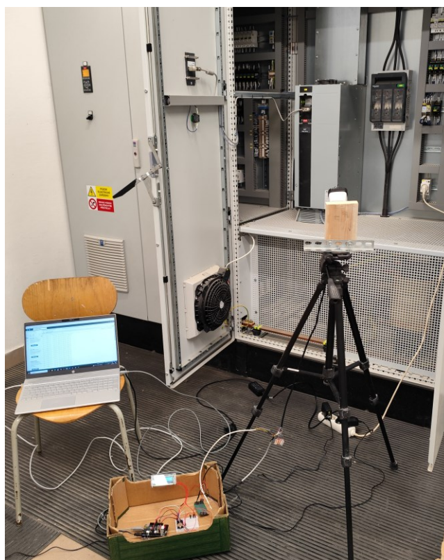
Obrázek 94 Instalace kamery na ČSOV Ponětovice [vlastní]
