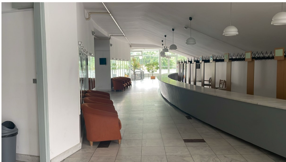
Obrázek 47 Stávající stav šaten
