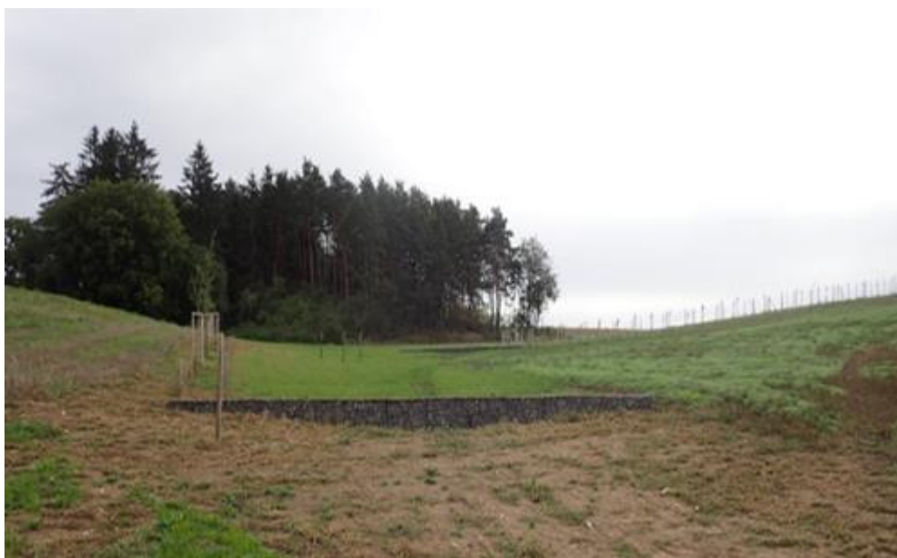
Obrázek 28 Ukázka gabionových přehrážek u obce Říčky [89]
