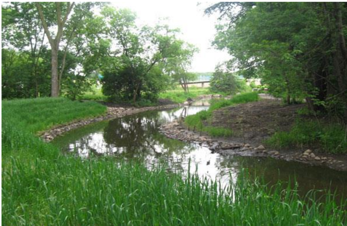
Obrázek 26 Ukázka stabilizace břehů kombinací zatravnění a výsadby stromů [90]
