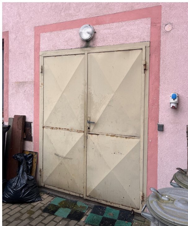
Obrázek 23 - Technická dílna školníka – pohled na dveře z venku
