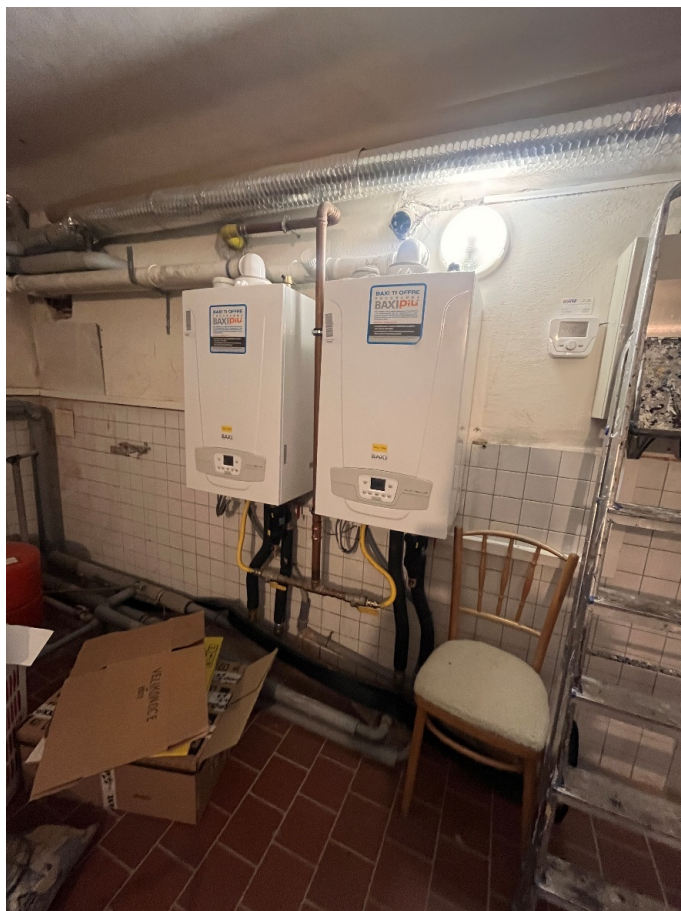
Obrázek 18 Pohled při vstupu do kotelny
