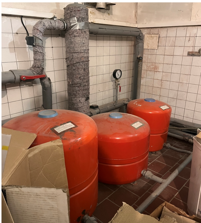
Obrázek 19 Pohled při vstupu do kotelny II.
