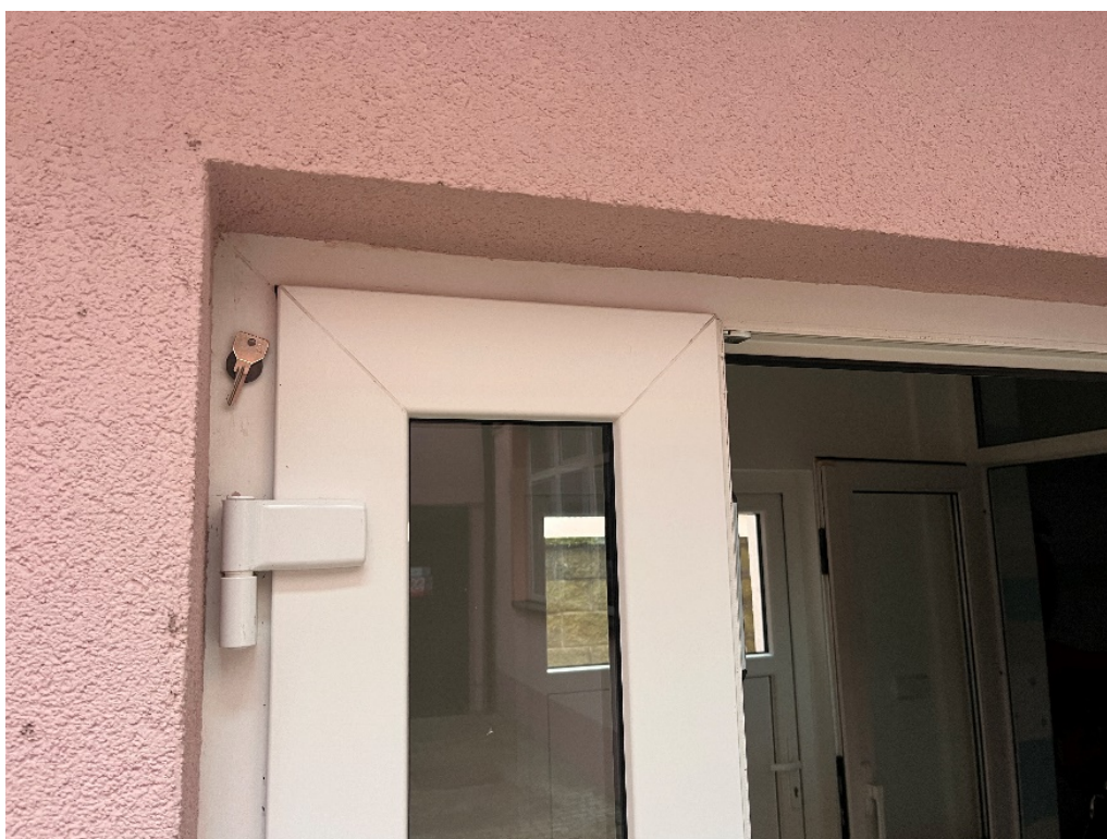
Obrázek 15 Úschova klíčů od výše uvedených dveří
